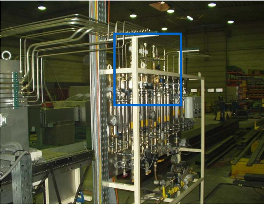
Aquí se puede ver una válvula modelo NV 200 en un panel de gas para gas de proceso y gas suplementario (gas natural, amoníaco). El panel abastece a un horno que se utiliza para carburar o sea templar acero.
